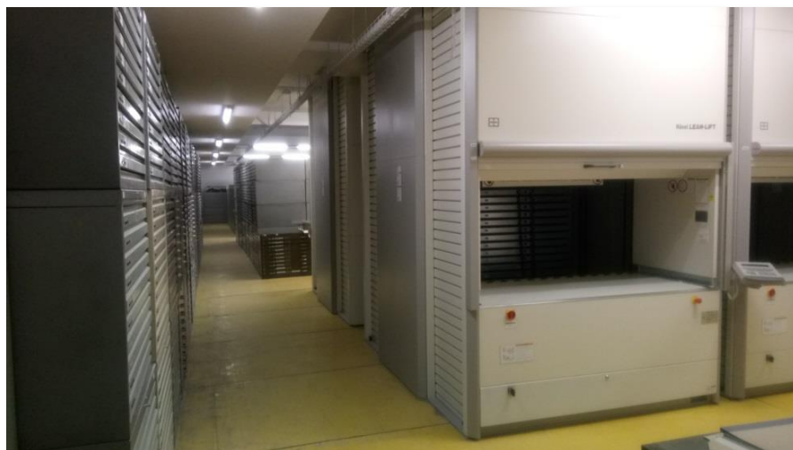
Archívne priestory po čiastočnej rekonštrukcii
