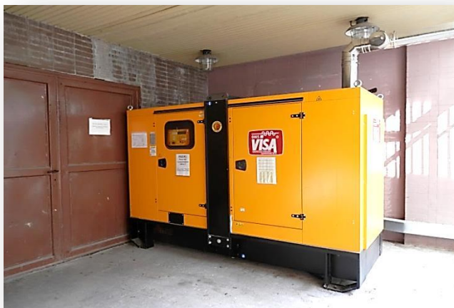
Motorgenerátor rady ONIS VISA s motorom IVECO na GKÚ
